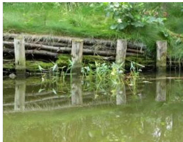
Abb. 12: Teil der Böschungssicherung mit Pfeilkraut-Bestand
