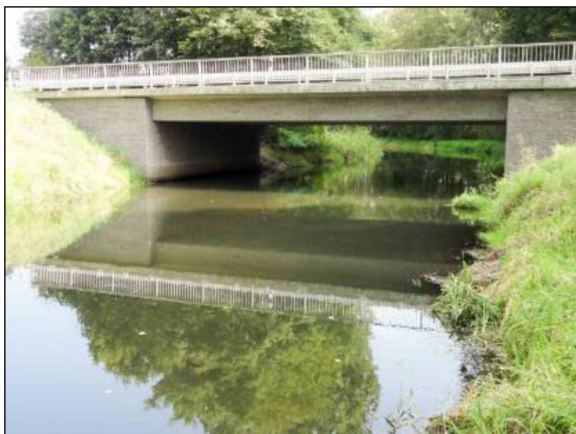
Abb. 19: Straßenbrücke der B 246 über die Nieplitz – aufgrund fehlender Bermen hohe Ottergefährdung (Foto: H. Hartong)
