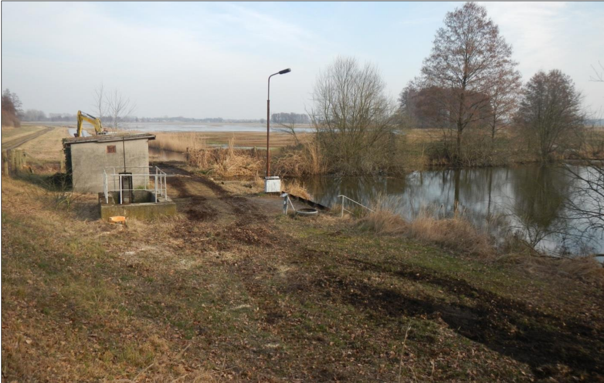
Abb. 8: Schöpfwerk Süd, im Hintergrund die Niederung der ehemaligen Wasserburger Spree (Februar 2019)
