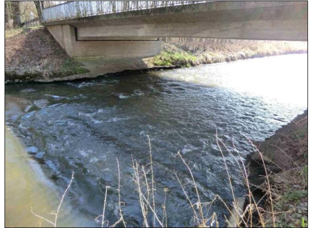
Abb. 12: Brücke 195 bei Babekuhl am südlichen Rand des FFH-Gebietes mit horizontaler künstlicher Berme und Sohlrausche (rechtes Bild) bei km 41,8 (Foto: Institut biota GmbH 2012, aus dem GEK – Bauwerkskataster)
