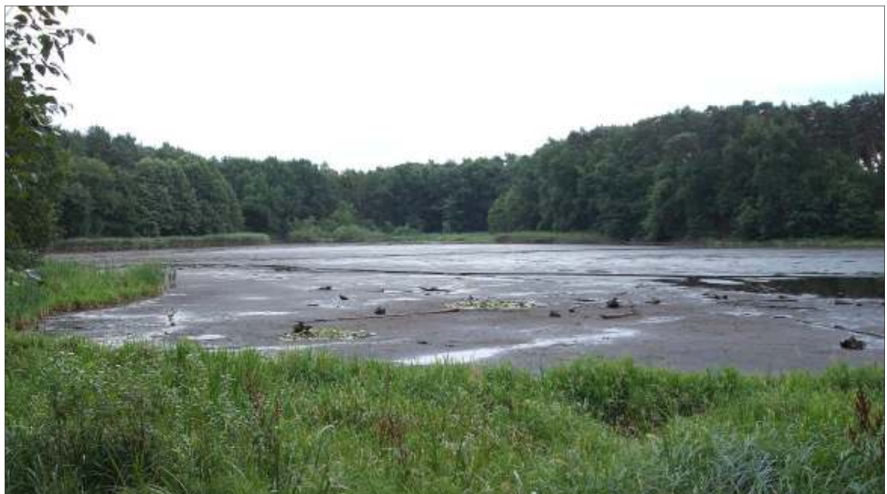
Abb. 11: Der Mühlenteich während der Baumaßnahme zum Ersatzneubau des Durchlasses (zur Entkoppelung vom Dossespeicherwasserspiegel) in 2010 (Quelle: Archiv der UWB OPR)
