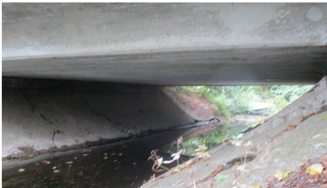
Abbildung 13: Beiderseits schräge Bermen am Brückenbauwerk der L29 in Ützdorf (Hoffmann, 21.09.2021)
