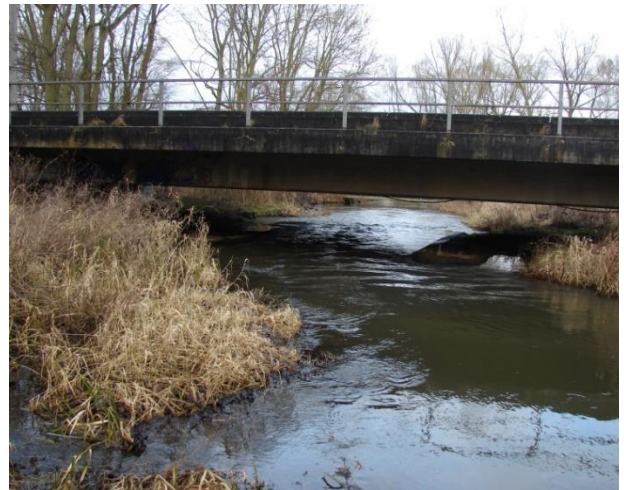
Durchlass der Buckau unter der Bahnlinie
