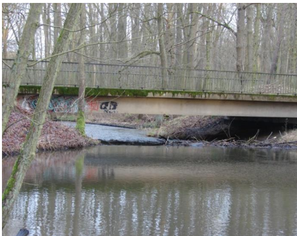
Durchlass der Buckau unter der Heerstraße
