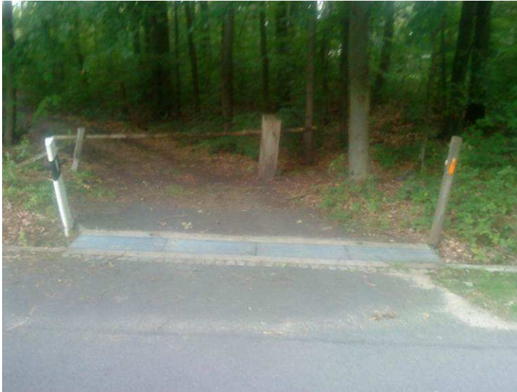
Abb. 35: Querungsgitter an der Parstein-Pehlitz-Straße
