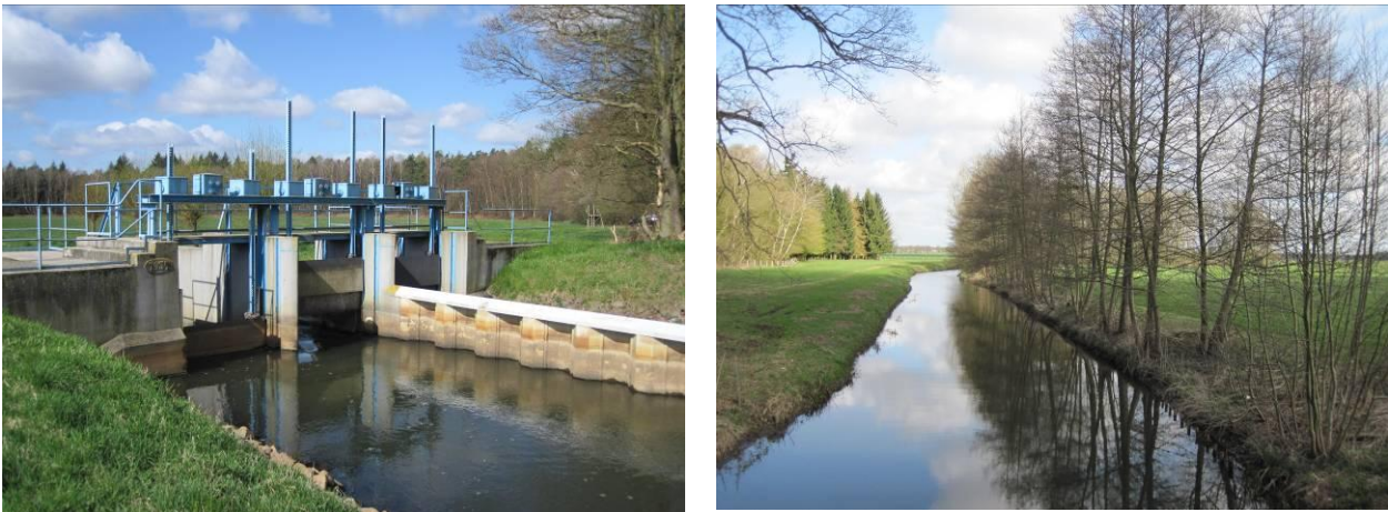
Abb. 14: Wehr Stavenow bei km 53,0 (linkes Bild) und Löcknitzverlauf mit schmalen, einseitigem Gehölzstreifen bei km 54,1 (rechtes Bild) (Fotos: I. Wiehle, 16.04.2015)
