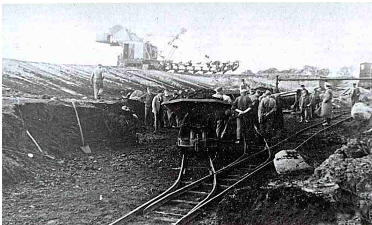
Abb. 11: Abraumbeseitigung mittels Eimerkettenbagger im Tagebau A, Aufnahme aus der Gewinnungsperiode 1946-1949 (aus PINZKE 2012, Quelle Foto: G. JAHNCKE).
