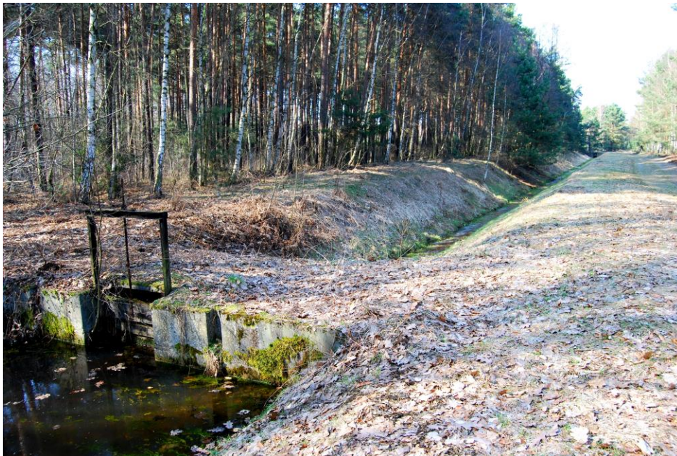
Abbildung 4: Graben mit Stauwerk in zentraler Lage des FFH- Gebietes
