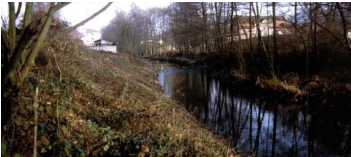
Abb. 29: Beispiel für die Umsetzung einer Flussaufweitung. Gehölze wurden zur Gewässeraufweitung entfernt (JANNY & GEITZ 2013)
