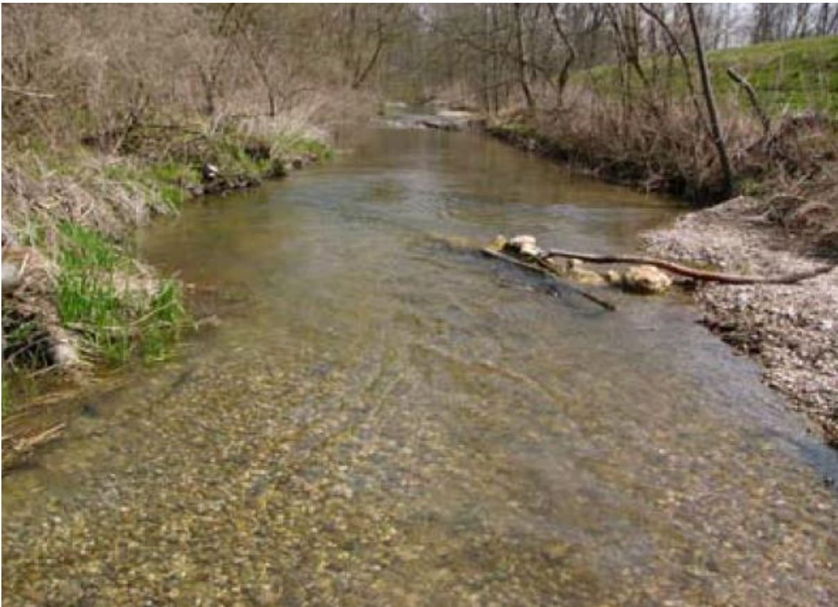
Abb. 26: Beispiele für Gewässerrestaurierungen zur Gestaltung von Kieslaichplätzen mit erhöhter struktureller Vielfalt. Hier sorgt eine kleine Buhne für Seitenerosion und Gumpenbildung. Die erhöhte Strömung im Bereich der Rausche sorgt für ein gut durchspültes Laichsubstrat. (PULG 2006)
