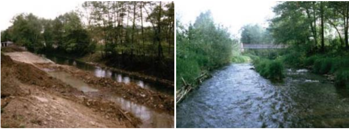
Abb. 30: Links – Beispiel für die Umsetzung einer Gewässeraufweitung. Es werden die Erdarbeiten zur Gewässeraufweitung gezeigt (JANNY & GEITZ 2013). Rechts – Beispiel für die Umsetzung einer Gewässeraufweitung. Vegetationsentwicklung nach 2-3 Jahren. Zu beachten ist die wesentlich turbulenterere Strömung im Vergleich zur Ausgangssituation (JANNY & GEITZ 2013).
