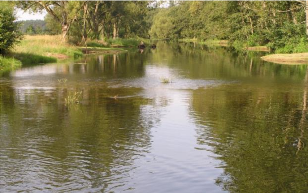
Abb. 19: Stumpf II. Im Vordergrund die leicht überströmte Schwelle und am rechten Ufer die eingebauten Sandbuhnen.
