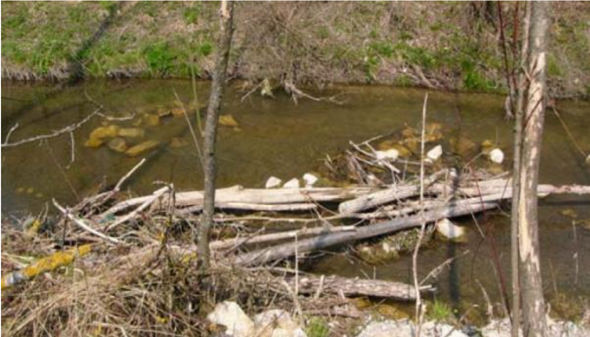
Abb. 27: Beispiele für Gewässerrestaurierungen zur Gestaltung von Kieslaichplätzen mit erhöhter struktureller Vielfalt. Das Bild zeigt Unterstände aus Totholz und Steinblöcken, dazwischen befinden sich Kiesbänke als Laichhabitats. (PULG 2006)
