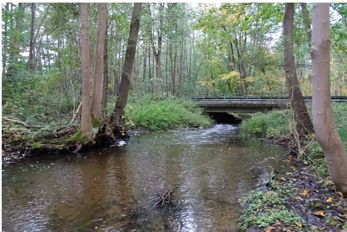
Abb. 46: Unterführung der Ragöse unter der L291
