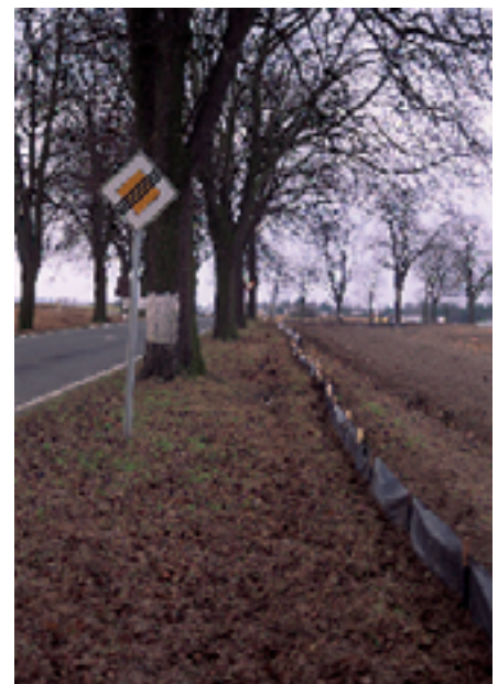
Abb. 3 Provisorischer Folienzäun an der Börnicker Chaussee (Barnim). Foto: N. Schneeweiß
