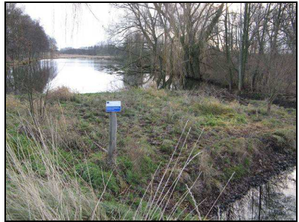
Abbildung 44: Rohrlacker Grabenniederung – LWH-Maßnahme am SW-Mahlbusen (Sohlschwelle eingebaut, 15.12.11, Foto: Rowinsky)
