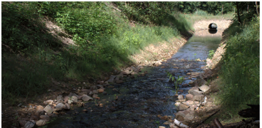
Abb. 5-6 – unten Auch in den Sommermonaten sind die Wasserstände in der Löptener Fenne nun stabil (06.08.2014) Foto: H. Rößling
