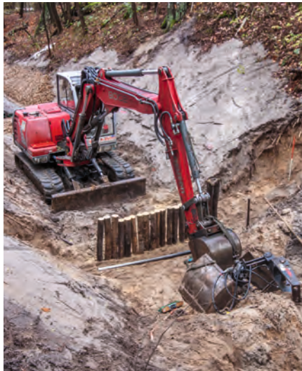
Abb. 5-3 – oben Die Sohlgleite ist mit einer Pfahlreihe gesichert (07.11.2013) Foto: H. Rößling
