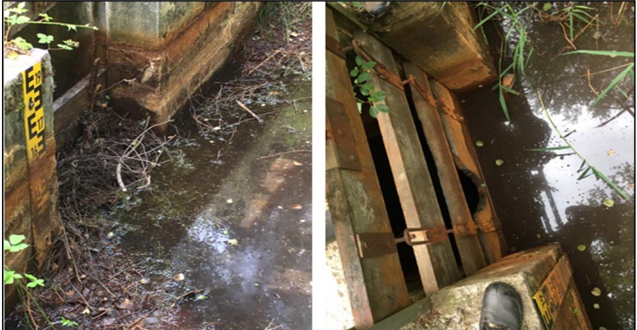
**Abb 10: Defekte Wehre am Pegel P2 (linke Seite: fehlende Holzbretter im oberen Teil) sowie am Pegel P3 (rechte Seite: Loch im Brett sowie mehrere offene Elemente) (ECOSAX GmbH 2019)**
