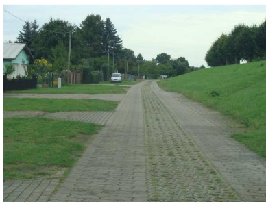
Bild 1: DVW nach dem Hochwasser im Juni 2013
