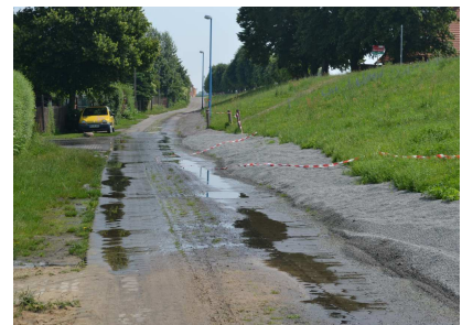
Bild 3: Stabilisierung des landseitigen Deichfuß mit Schotterauflage
