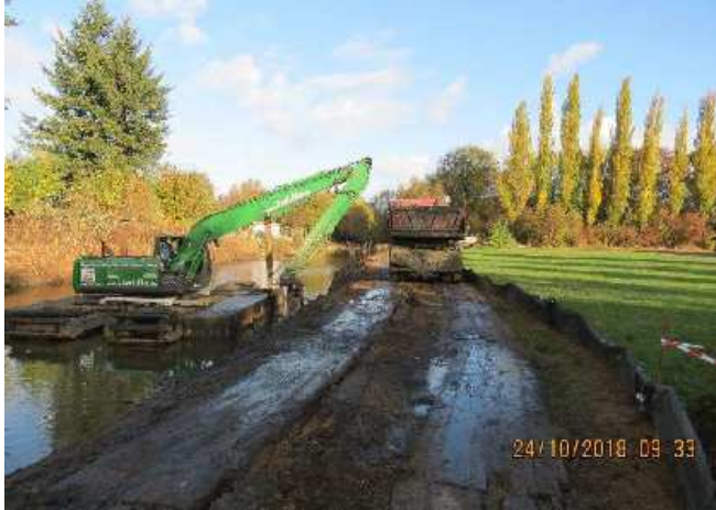
Volzine Station 0+190 zum Bauanfang (Nassbaggerung)
