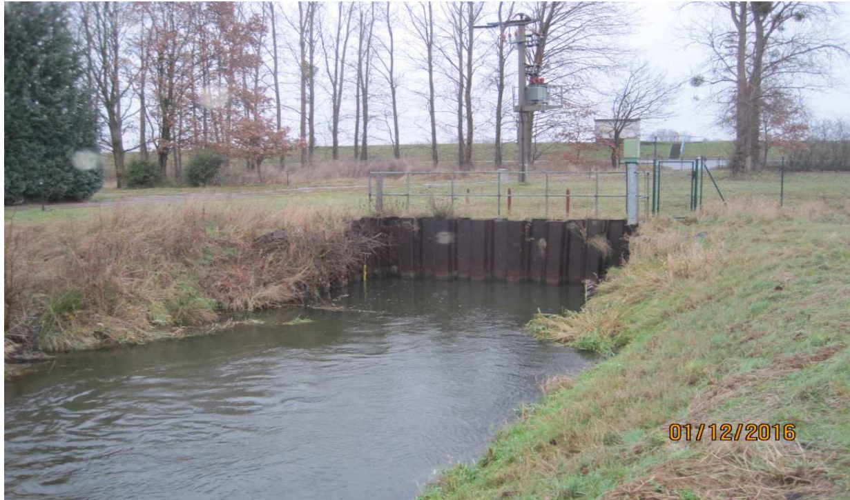
Abbildung 4: Aktuelles Auslaufbauwerk mit Blick in Richtung Deich
