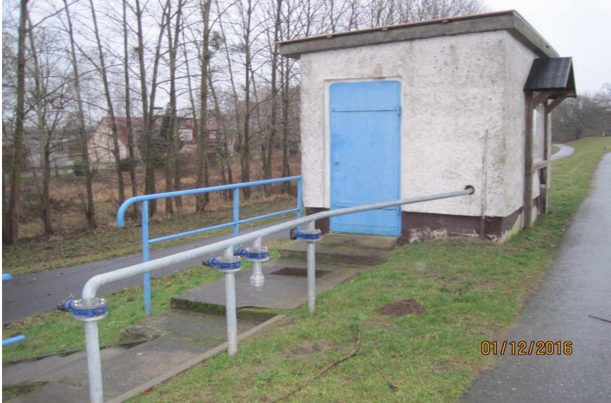
Abbildung 3: Deichkrone mit aktuellem Betriebsgebäude und Evakuierungsleitungen
