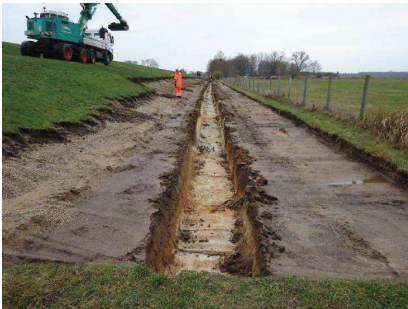
Herstellen Entlastungsschlitz
