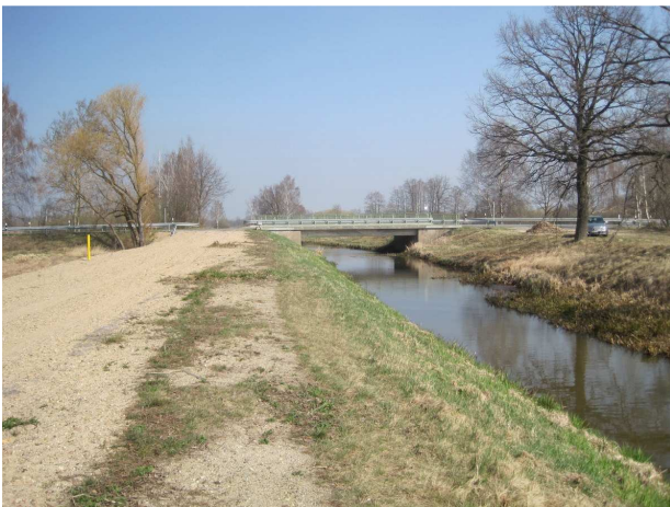
Foto 1: Straßenbrücke Station 1 + 340 (Blick in Fließrichtung)
