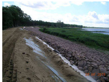
Bild 2: Sicherung der Wasserseite
