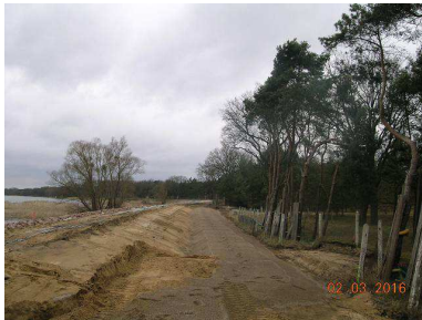
Bild 1: Filtereinbau
