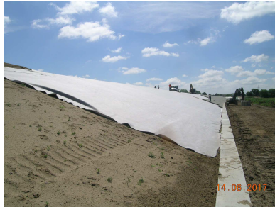
Bild 2: Abdeckung mit Geotextil
