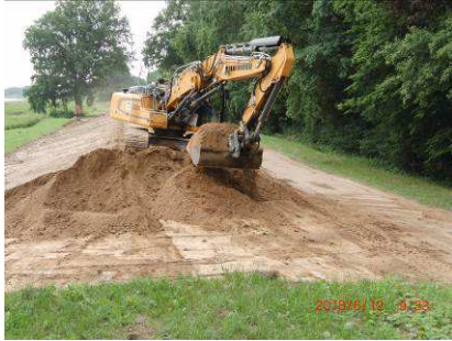
Abbaggern des Altdeiches
