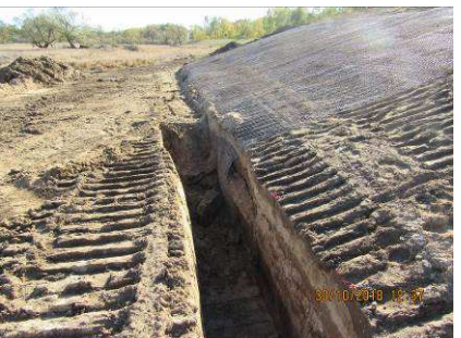
Einbau Biberschutzgitter
