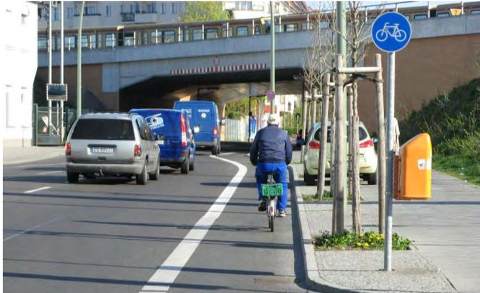
Der **Schutzstreifen** wird ebenfalls auf der Fahrbahn markiert und darf in Ausnahmefällen, z.B. bei Begegnungsverkehr, vom fließenden Kfz-Verkehr ohne Gefährdung des Radverkehrs mitbenutzt werden. Die Regelbreite beträgt 1,50 m, mindestens sind 1,25 m vorzusehen (vgl. RAS 06). Das Parken ist auf dem Schutzstreifen nicht zulässig. Schutzstreifen sollten dann angeordnet werden, wenn Radfahrstreifen nicht zu verwirklichen sind.
