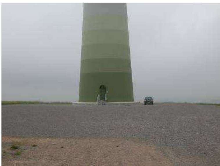
Abb. 3-19: Mast der WKA 28 (Enercon E112) im WP Druiberg mit großflächig geschottertem Vorplatz.
