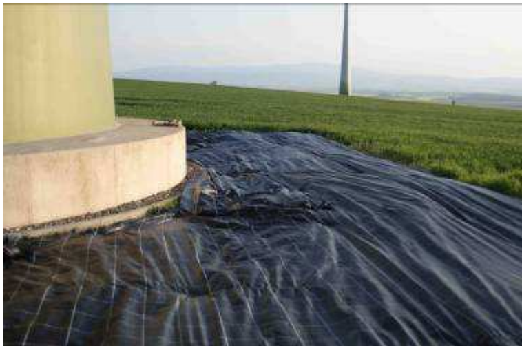
Abb. 3-17: Mit Folie abgedeckte Mastfußbrache.
