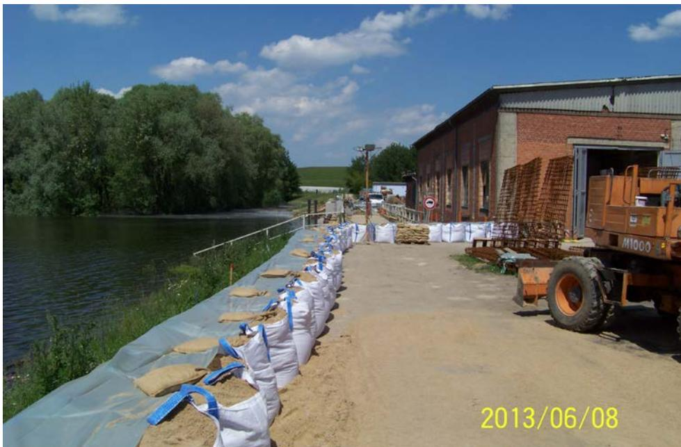
Abb. 47: Sicherungen im Bereich der Baustelle Schöpfwerk Karthane
