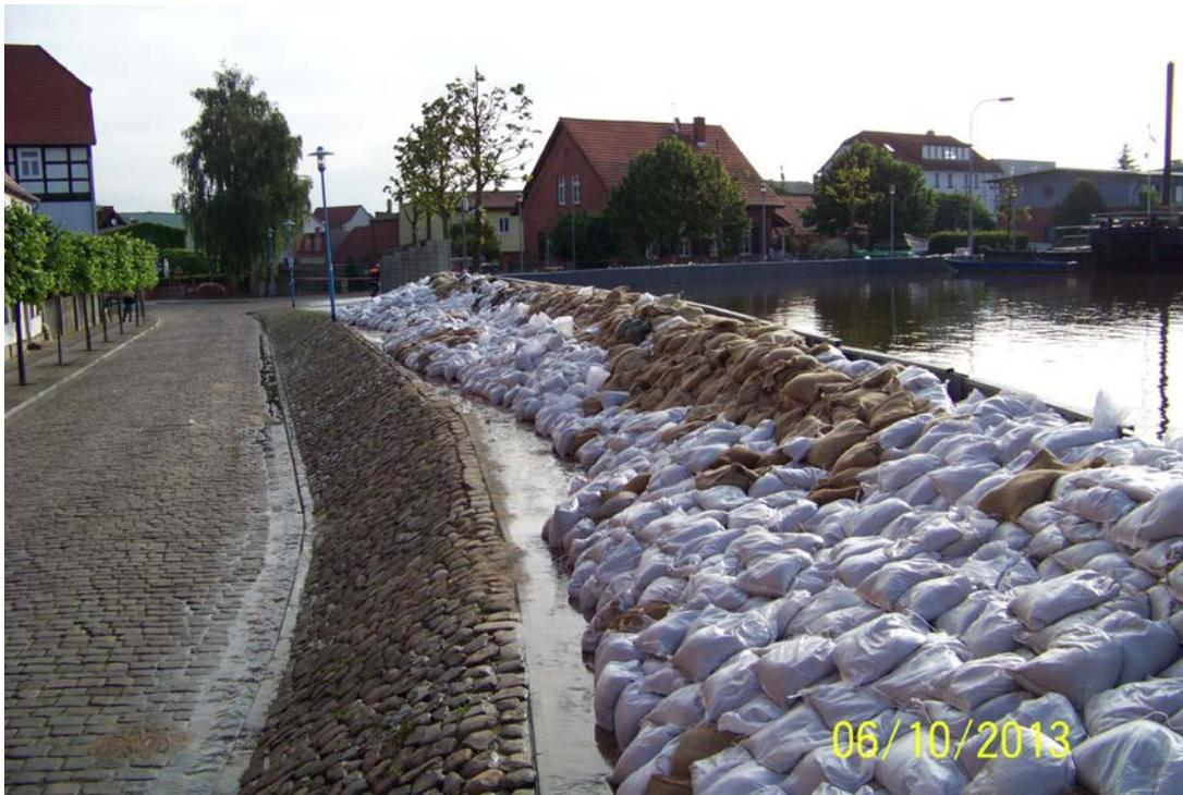
Abb. 41: Verstärkte Spritzschutzwand im Bereich der Elbstraße/ Hafen Wittenberge
