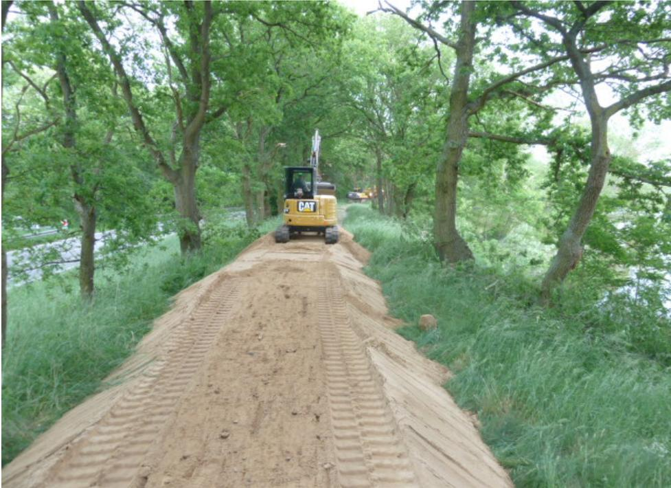
Abb. 39: Erhöhung der Düne Cumlosen
