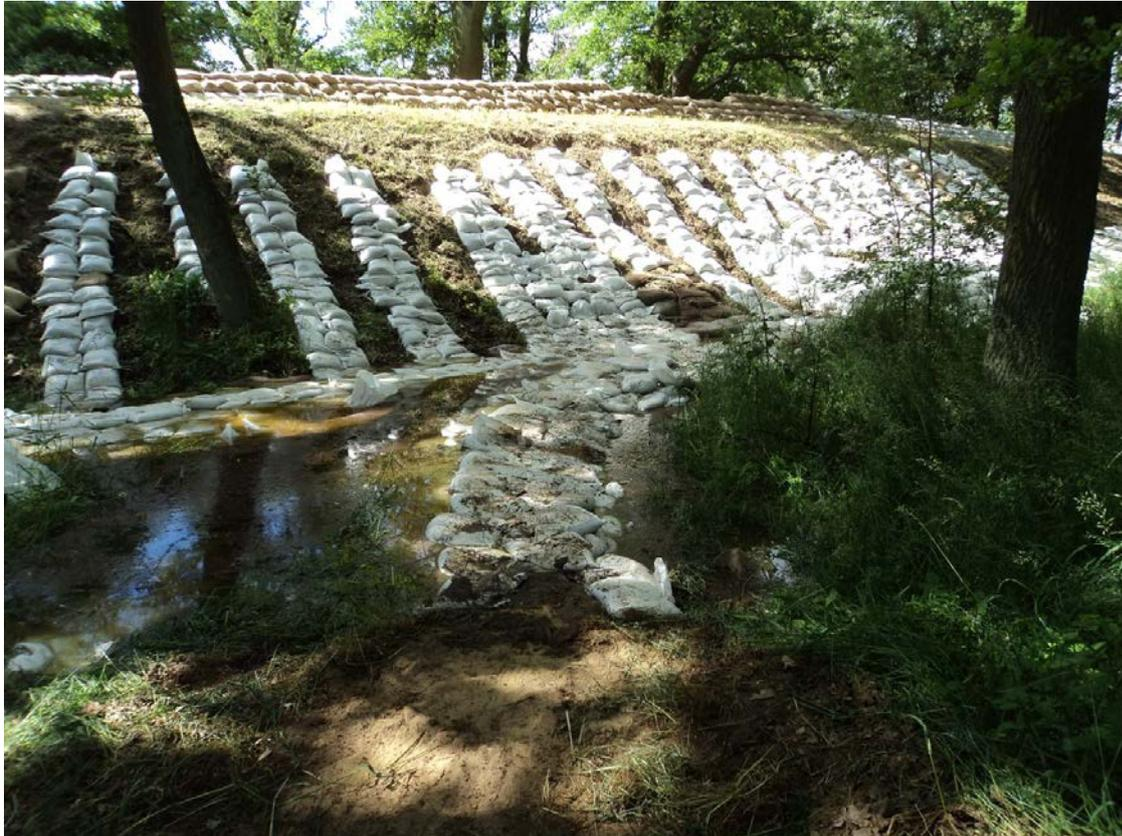
*Abb. 44: Aufkadtungen und Böschungssicherungen bei Scharleuk*
