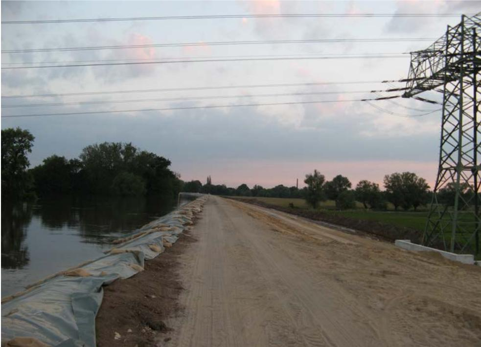
Abb. 46: Wasserseitige Böschungssicherung und Berme im Baulos 11
