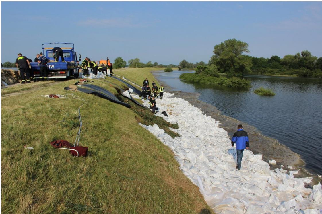
Abb. 49: Böschungssicherung zur Vermeidung weiterer Rutschungen am Mitteldeich
