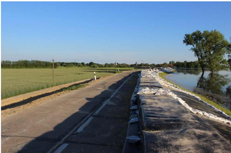
Abb. 48: Neue Berme und Aufkadung mittels Strohquadern auf der Straße zwischen Bälów und Sandkrug
