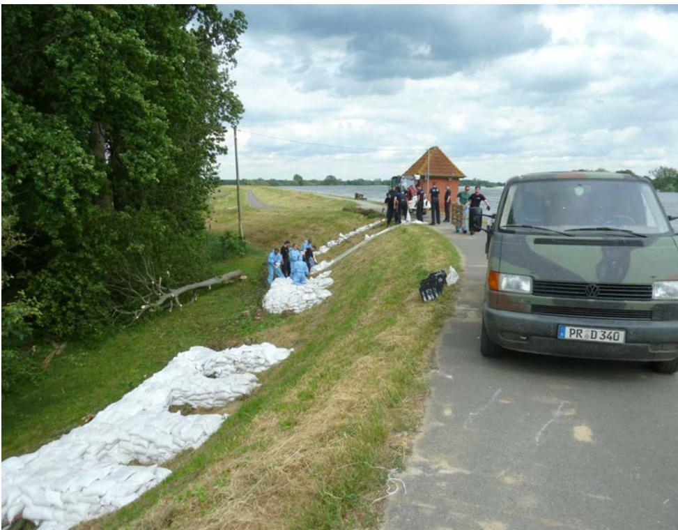
Abb. 40: Böschungssicherungsmaßnahmen (mit Schutzmaßnahmen gegen EPS)
