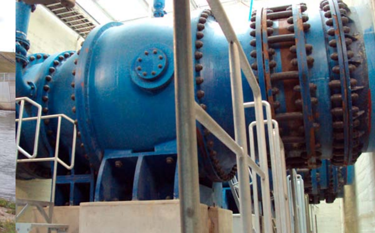
Ringkolbenschieber
