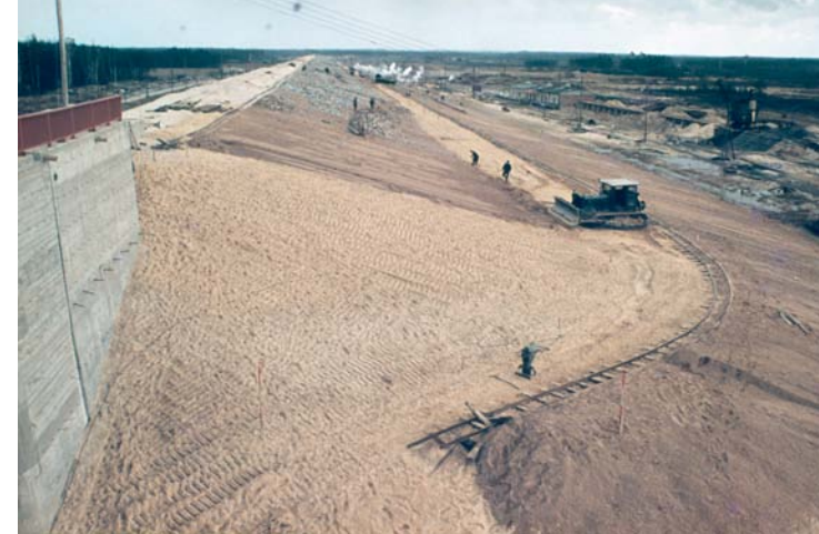
Der Damm im Bau
