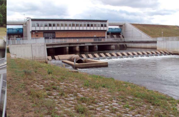
Hochwasserentlastungs- und Grundablassbauwerk
