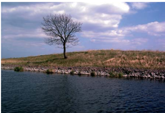
Deckwerke prägen heute über drei Viertel der Ufer. (Foto: R. Buchta)
