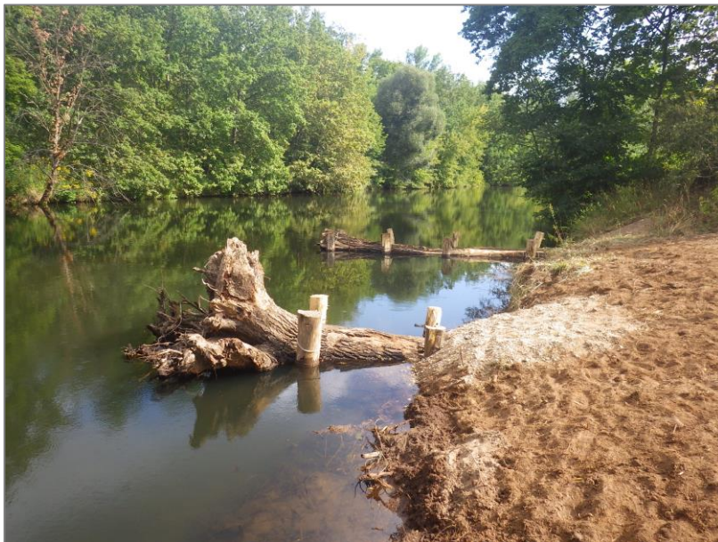
Abbildung 5.2: Beispiel Wurzelstammbuhne
