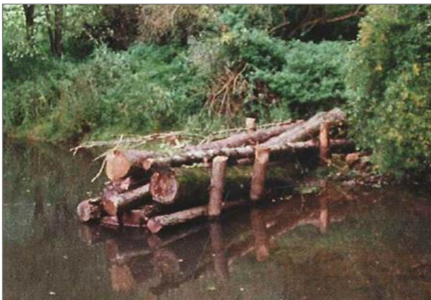
Abbildung 5.1: Beispiel Ausfachungsbuhne
