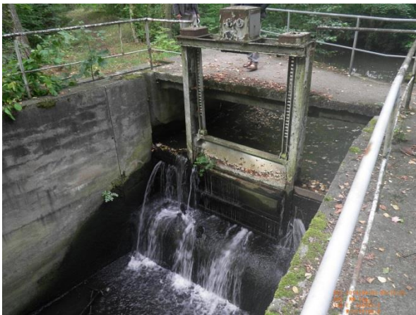
Abbildung 3.26: Korrosion und Leckagen
