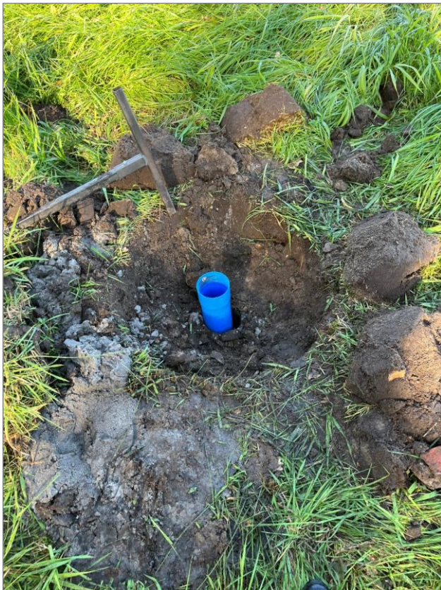
Foto 9: Rückbau temporäre Grundwassermessstelle
