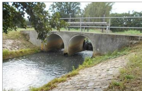
Abbildung 2.6: Wehr B101 aus dem UW
