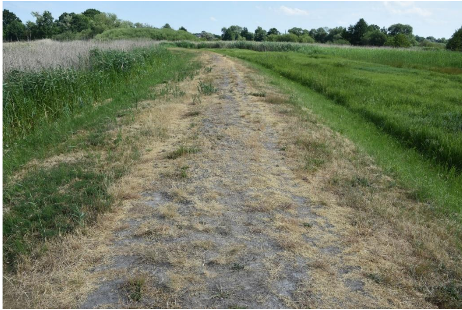
Abb. 3-1: Strukturarmut und verdichtete Bodenverhältnisse auf Deich im Juni 2023 (UBB).
