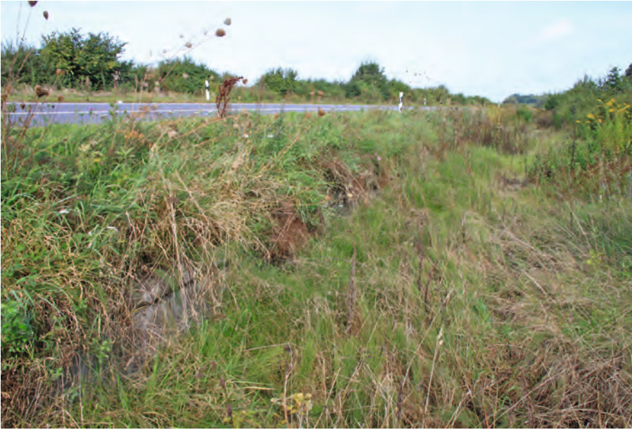
Abb. 5 Eine Leiteinrichtung im Landkreis Prignitz lässt sich wegen fehlender Mahd unter der überhängenden Vegetation nur noch erahnen und kann von Amphibien ohne weiteres überklettert werden. Auch die zugewachsene Lauffläche stellt für wandernde Tiere einen hohen Raumwiderstand dar Foto: S. Jansen
