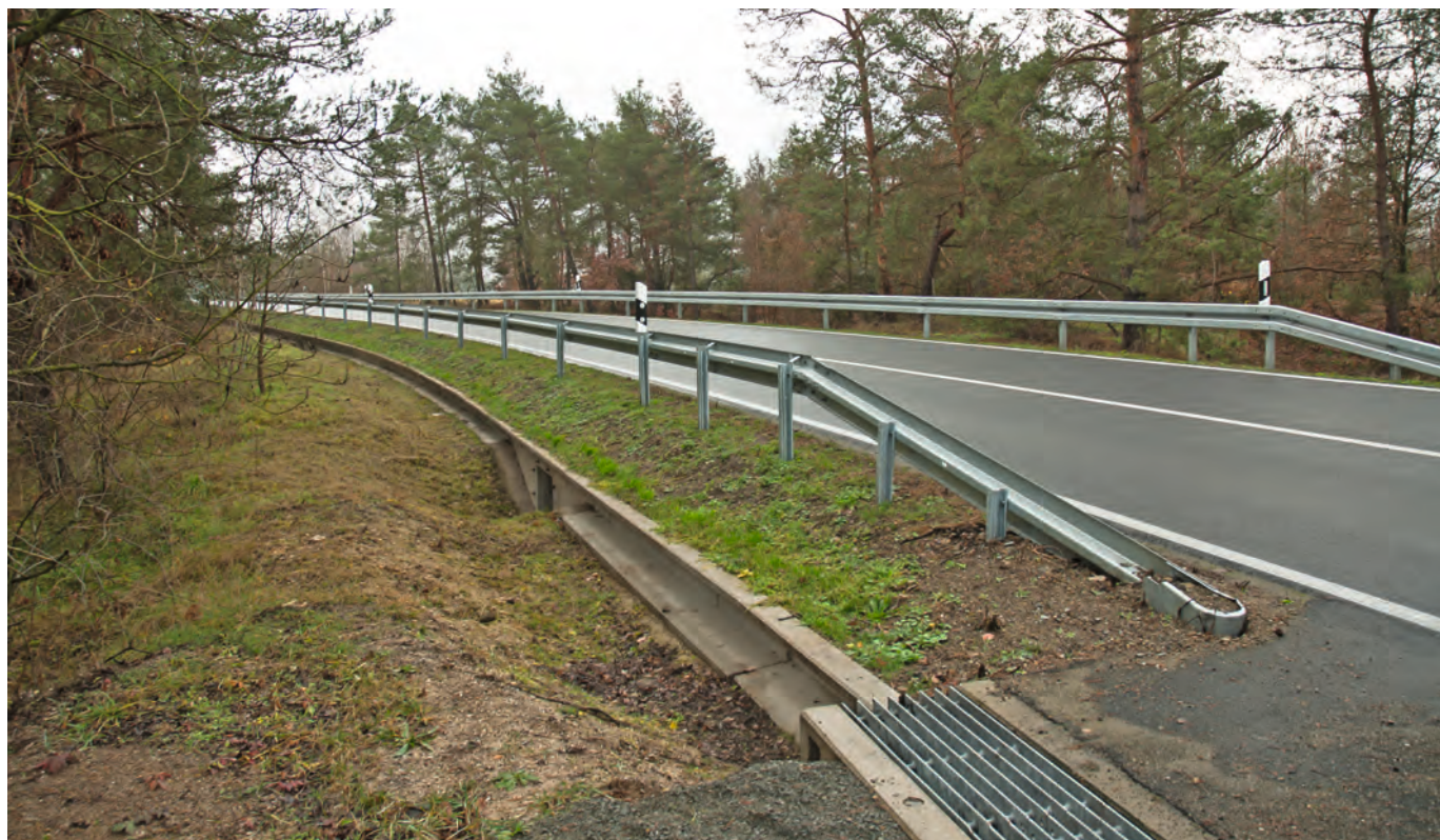
Abb. 11 Massive Anlagen aus Stahlbeton mit großlumigen Durchlässen haben sich bewährt (Anlage am Kiesschacht Ponnisdorf, Landkreis Elbe-Elster) Foto: N. Schneeweiß
