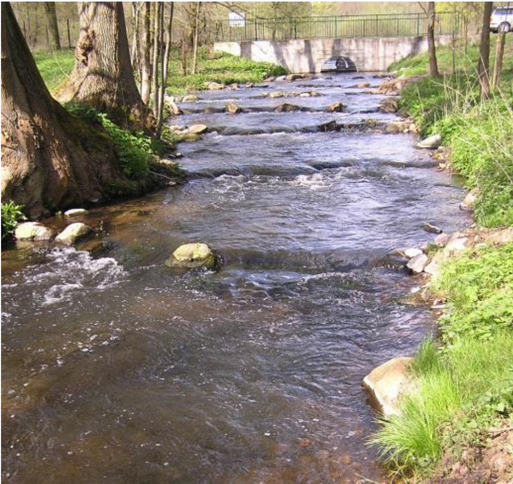
Abb. 5: Naturnaher Beckenpass in Klein Wall
