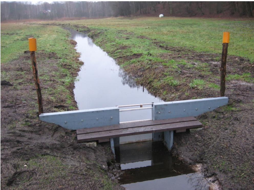
**Abb. 10: Moorgrabenstauanlage „Typ Beeskow“ (Foto: WBV „Mittlere Spree“)**
