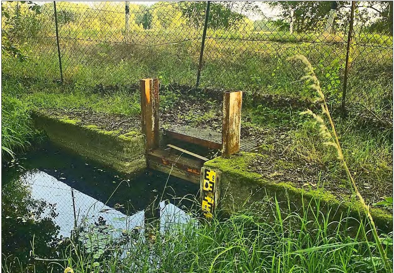
Abb. 5: Stau am Abfluss des Byhleguhrer Sees (Byhleguhrer Seegraben) an der L51 (Juni 2019)
