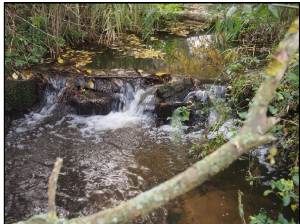
Abb. 4: Sohlabsturz an ehemaligem Wehrstandort
