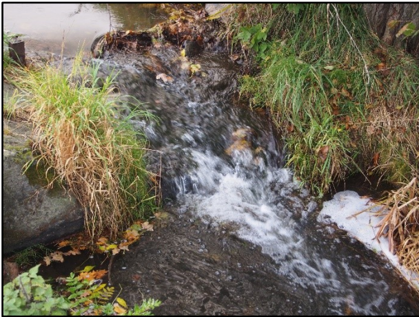
Abb. 3: Sohlabsturz an ehemaligem Wehrstandort
