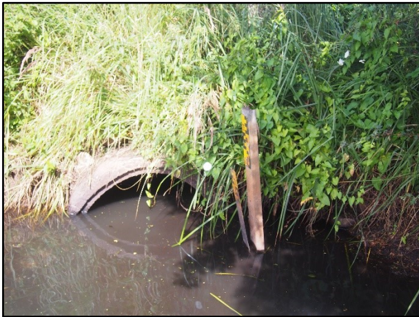
Abb. 32: Befischungsstrecke 1.2 im Großen Kanal mit Rohrdurchlass
