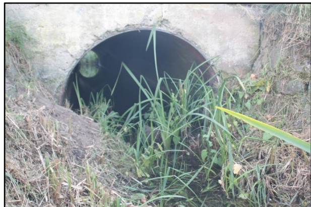
Abb. 17: Straßenunterführung Neschholz nördlich der B246
