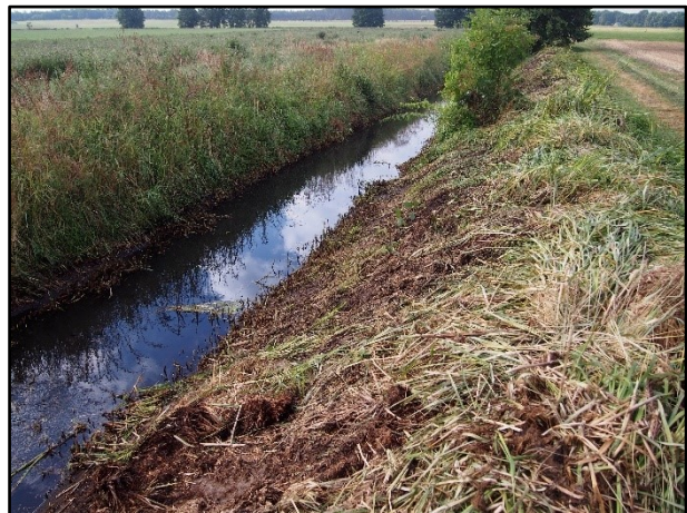
Abb. 31: Befischungsstrecke 1.1 im Großen Kanal nach sehr intensiven Gewässerunterhaltungsmaßnahmen
