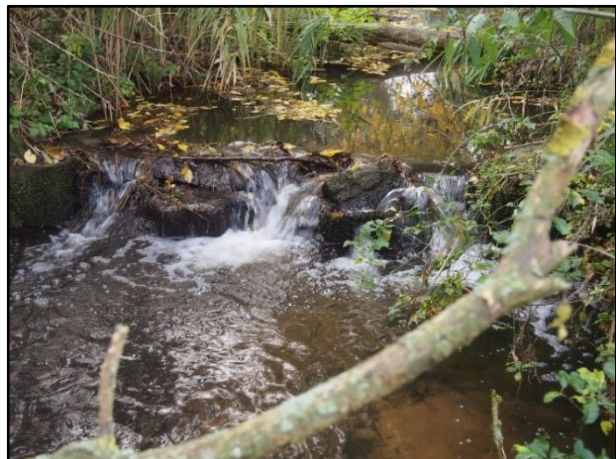
Abb. 46: Sohlabsturz an ehemaligem Wehrstandort
