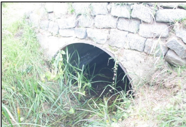
Abb. 16: Straßenunterführung Neschholz südlich der B246
