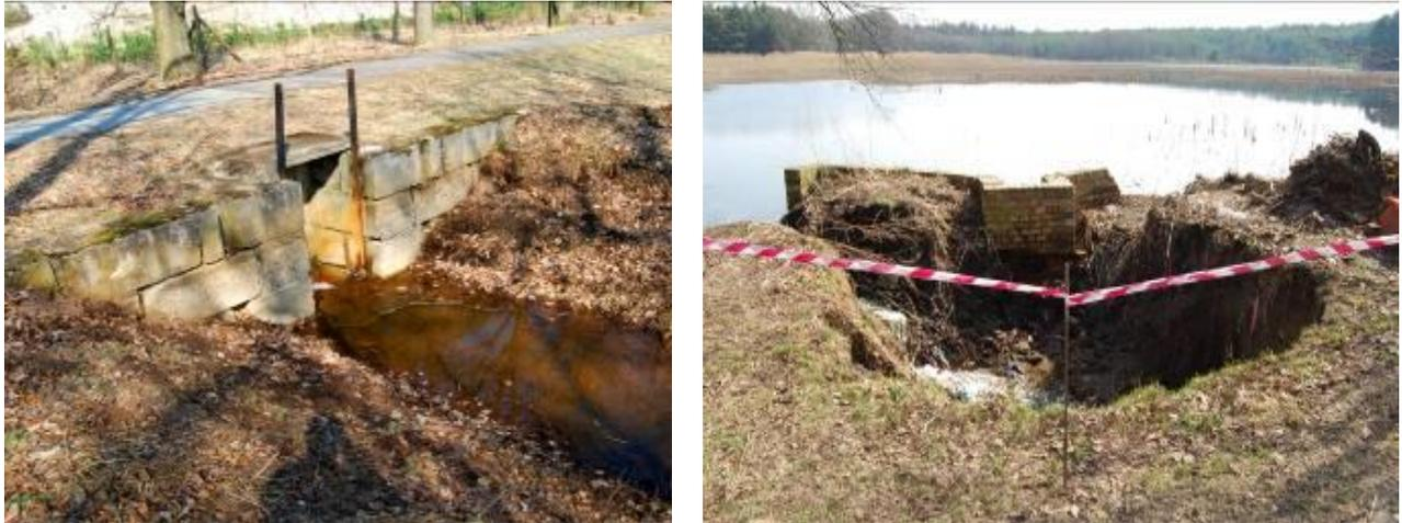
**Abbildung 8:** links: Durch HW beschädigtes Abflusssystem, Weg weggespült;
