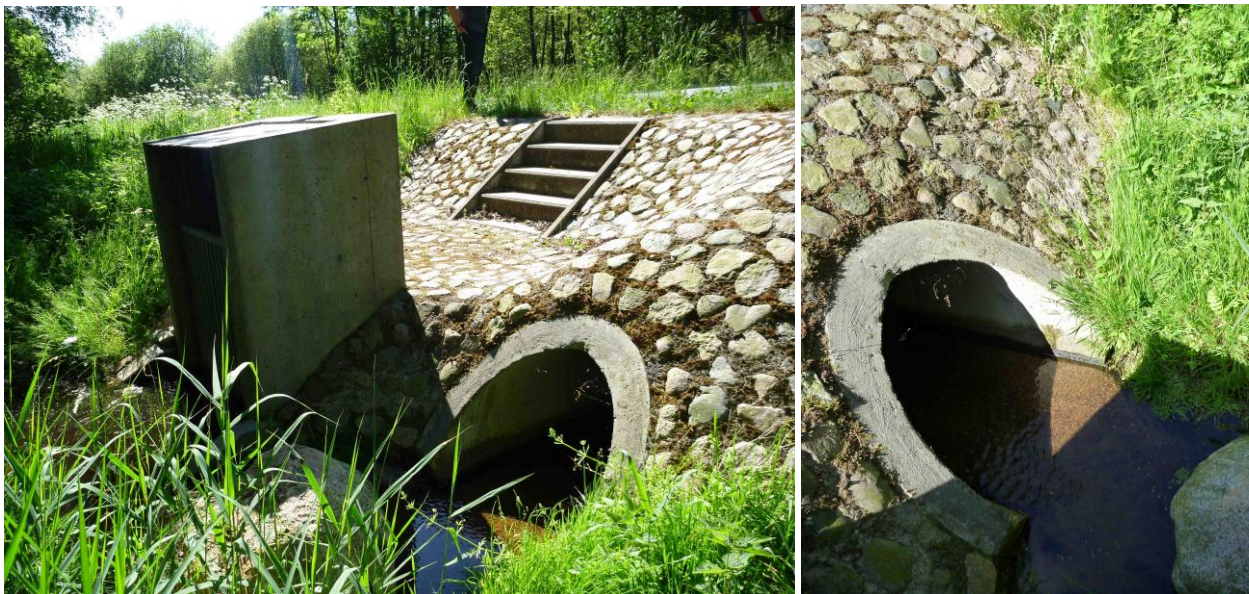
Abb. 11: Querung des Rhin (Werbellinseegraben) unter der K 6802 gegenwärtig mittels Düker und Trockenröhre (Trockenröhre zum Zeitpunkt der Aufnahme allerdings wassergefüllt → als Querungshilfe für den Fischotter eher ungeeignet, Aufnahmezeitpunkt: Mai 2012)
