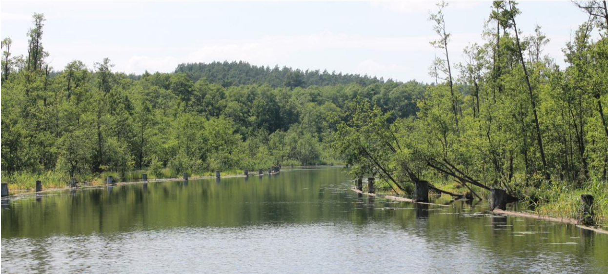
Abb. 8: Schutzvorrichtung des Ufers (Pfähle mit Schwimmbalken) in der Fristower Plagge (Foto: B. Schink)
