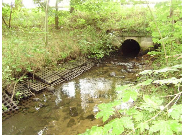
Abb. 10: Uferbefestigung (Betonplatten) unterhalb der Verrohrung an Landstraße L 19: hier sollte ein Rückbau der Uferbefestigung bzw. ein Umbau der Verrohrung erfolgen (RUNGE 2010)
