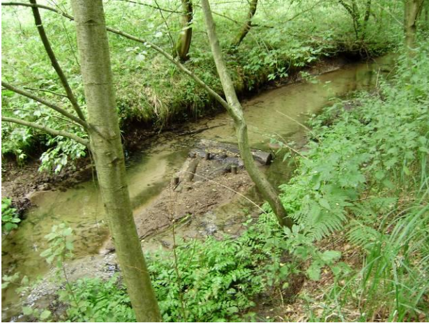
Abb. 9: Im Jahr 2009 erfolgter Totholzeinbau in der Lindower Beeke zur langfristigen Anhebung der Gewässersohle (RUNGE 2010)
