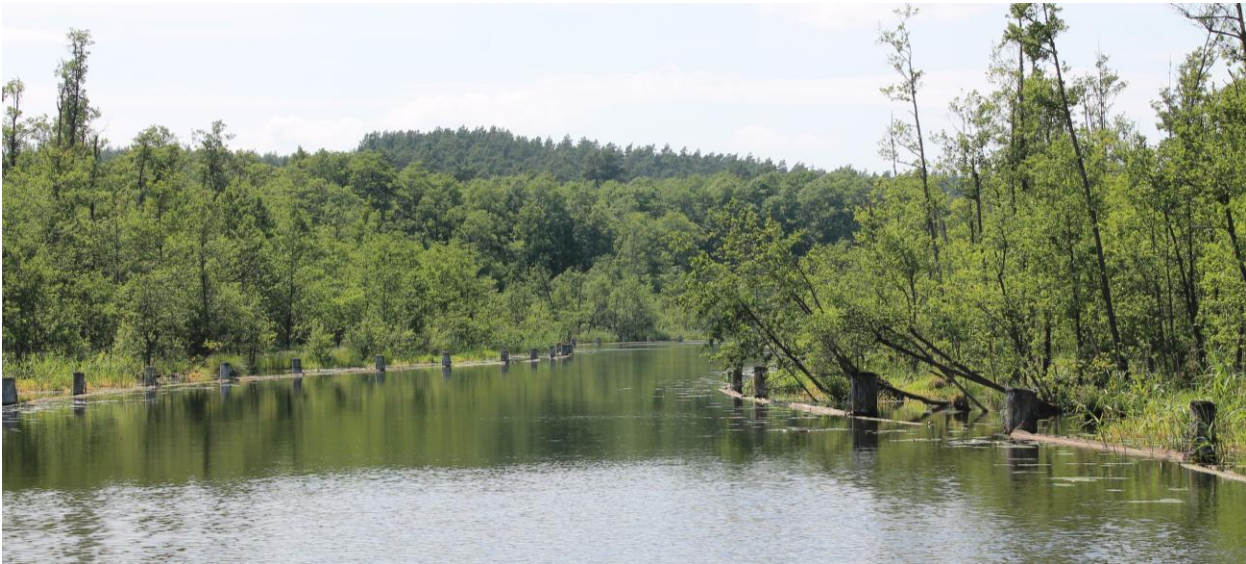
Abb. 1: Schutzvorrichtung des Ufers (Pfähle mit Schwimmbalken) in der Fristower Plagge (Foto: B. Schink)
