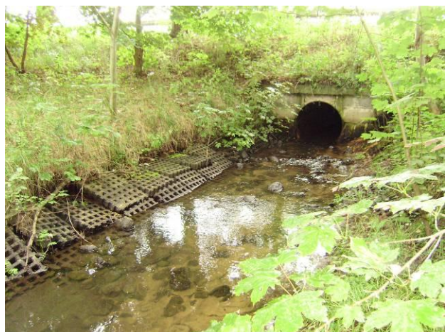
Abb. 2: Uferbefestigung (Betonplatten) unterhalb der Verrohrung an Landstraße L 19: hier sollte ein Rückbau der Uferbefestigung bzw. ein Umbau der Verrohrung erfolgen (RUNGE 2010)
