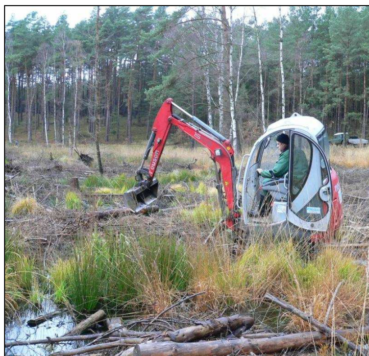
Abb. 7: Renaturierungsarbeiten im Teufelsbruch mit Flachabtorfungen (links) und Grabenkammerung (rechts) (Fotos: Oberförsterei Zechlinerhütte 2007)
