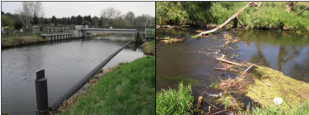
Abb. 16: Rieseleiwehr bei km 12,7 (links) und zerfallener Sohlabsturz aus Holzpalisaden (Reste) (rechts) (Fotos: I. Wiehle, April bzw. Juni 2015)
