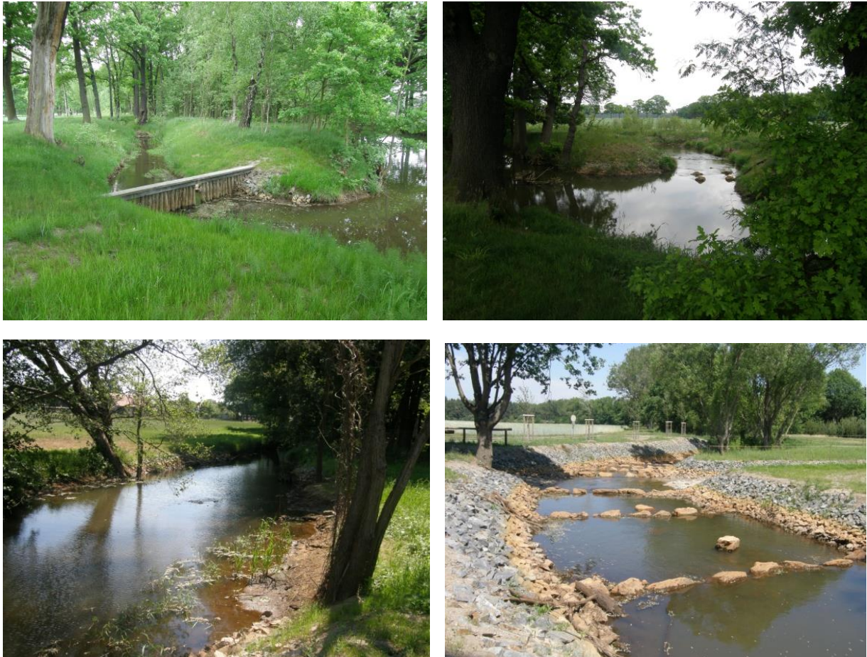
Abbildung 4: Maßnahmen zur Verbesserung der longitudinalen Durchgängigkeit im Flussabschnitt zwischen Jannowitz und Arnsdorf ( obere Abb. links: Verbindung zum Altarm am Wehr 26; obere Abb. rechts: Umgehungsgerinne am Wehr 28 nördlich von Jannowitz; untere Abb. links: Sieggraben bei Arnsdorf; untere Abb. rechts: Sohlrampe am Sieggraben, Juni 2011).
