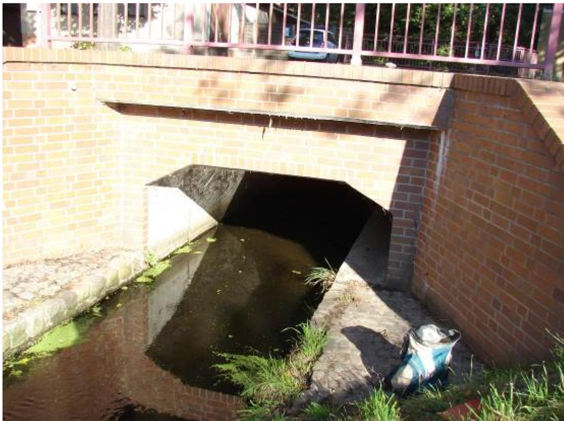
**Abb.12 Durchlass an der B 246 unmittelbar nördlich des FFH-Gebietes Müllergraben mit Otterberme**
