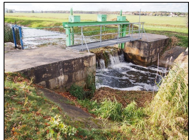
Abb. 15: Wehr an der Probestrecke mit angeschwemmtem Mähgut nach GU
