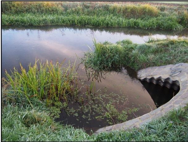
Abb. 22: Probestrecke/ Teilstrecke 5.1 (13,370775; 51,43434), Mündungsbereich Steiggraben mit ökologisch durchgängig gestalteter Brücke (HAMCO Profil)
