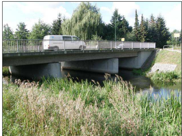
Abbildung 21: undurchgängiges Brückenbauwerk bei Trebbin
